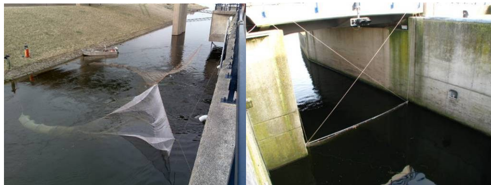
Figuur 22: Instromend zout water aan de zoete kant van de Krammerjachtensluis (boven) en fuikopstelling aan de zoete kant in doorgang Bergsediepsluis
